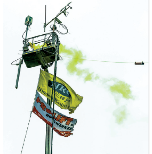
Gele rook markeert het begin van de jubileumviering. In de hoogwerker o.a. HF-dipolen, VHF/UHF rondstraler, 23 en 13cm-slotradiators en twee 3cm-parabolen.
